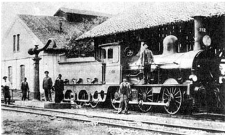
Строителство на жп гара Варна (ЦДА, ф. 3К, оп. 10, а.е. 48)
