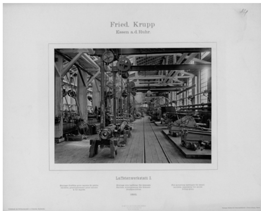
Заводите „Фридрих Крупп“, Есен; лафетен цех, монтаж на лафети за малък калибър скорострелни оръдия, 1892 г. (ЦДА, ф. 3К, оп. 7, а.е. 361, л. 14)
