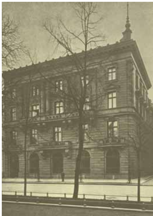
Централната сграда на банка Дисконтотезелшафт, 1851 г., останала неразрушена и през Втората световна война (Исторически архив, Дойче банк АД, Берлин)
